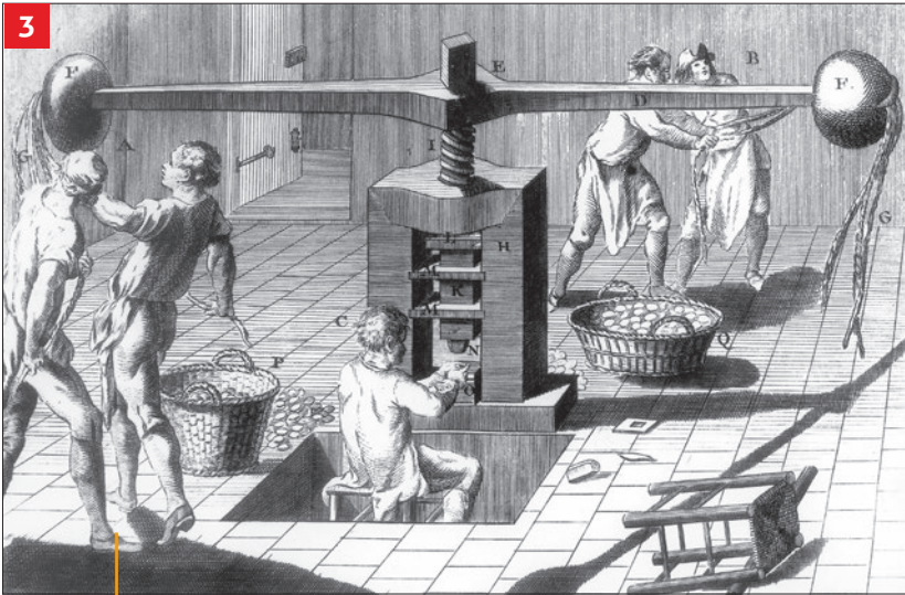
«Frappe de la monnaie au balancier à vis», gravure tirée de l' Encyclopédie sous la direction de Diderot et d'Alembert, Paris (F), vers 1750-1790.
