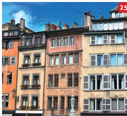
Au centre, maison surélevée au XVI e siècle, place du Bourg-de-Four, Genève.
