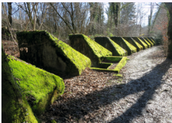
Protections antichars, ligne fortifiée de la Promenthouse, dite « ligne des Toblerones », Begnins (VD), construite entre 1937 et 1941.
